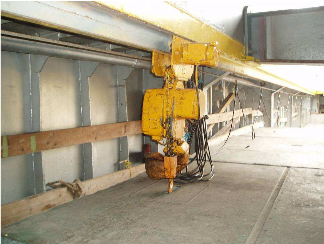
KITO kran (talje) brugt til at flytte pontoner
