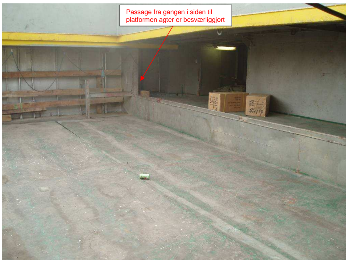
Mellemdæk set fra bagbord side, ponton 19 er lagt på plads
